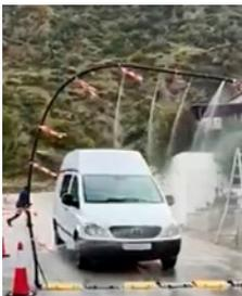
El funcionamiento de estos dispositivos es en cierto modo similar al de un fumigador, al rociar a modo de un spray en este caso agua a presión con desinfectante. La activación se produce mediante un sensor que activa los pulverizadores de forma Deben tener las ventanillas cerradas y mantener una velocidad de 10 km/h sin detener en ningún momento el vehículo.
